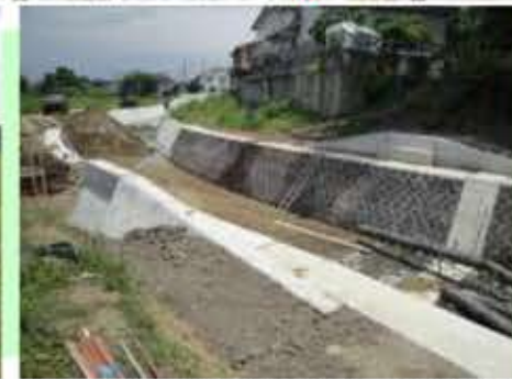
▲写真③ 砂防工事が行われる柳田川の周辺
