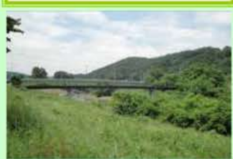
▲写真④ 水辺再生プランが行われる越辺川・山吹橋周辺
