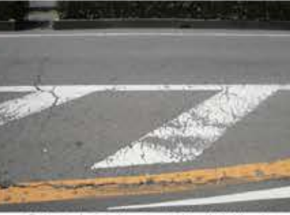
▲⑧飯能寄居バイパス舗装道整備(岩井西) 大型車の通行量が増え傷んだ面を補修
