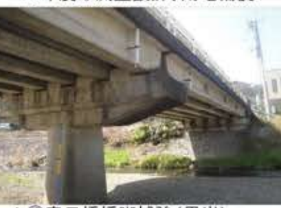
▲④春日橋橋脚補強(黒岩) 落橋防止装置の設置
