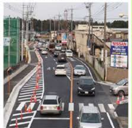
▲右折帯完成後の様子
