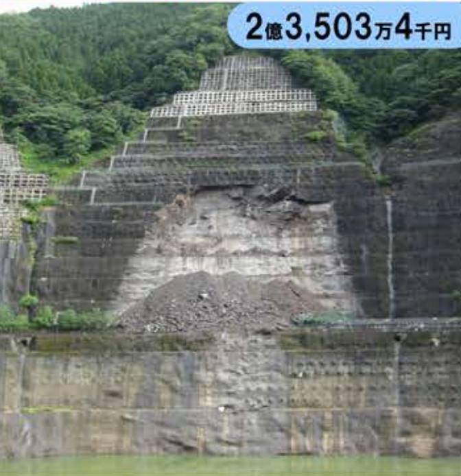
▲台風で法面崩落が発生した有間ダム（飯能市）
