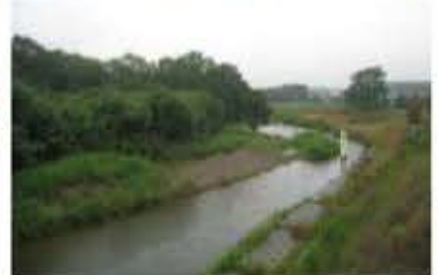
▲⑤越辺川河川改修(苦林地区) 測量・設計(250m)を継続
