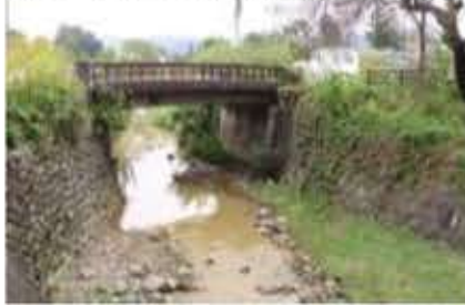
▲⑥大谷木川改修(長瀬地区) 鶴前橋 の上下流(360m)用地補償、工事
