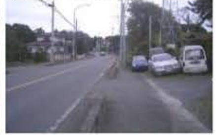
▲⑦歩道整備(川角地区) 航空自衛隊 川角送信所沿いの歩道拡幅
