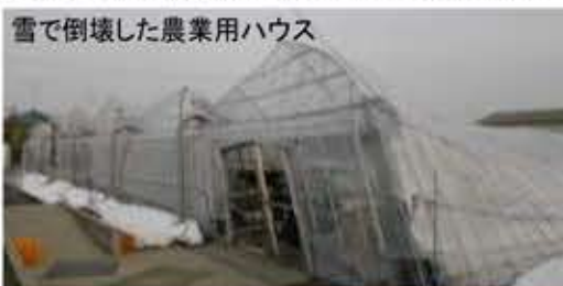
雪で倒壊した農業用ハウス
