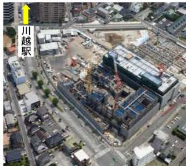
▲建設中の西部地域振興ふれあい拠点施設
