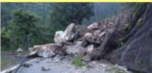
▲国道140号(秩父市内)の崩落現場
