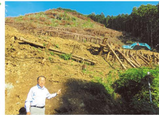
▲太陽光パネル設置工事現場(越生町)
