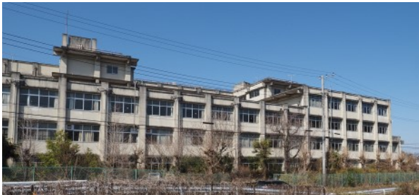
▲解体工事が始まる旧毛呂山高校跡地
