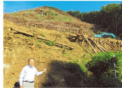
▲太陽光パネル設置工事現場(越生町)
