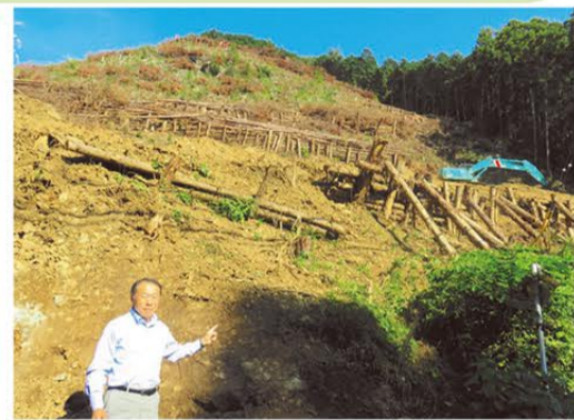
▲太陽光パネル設置工事現場(越生町)
