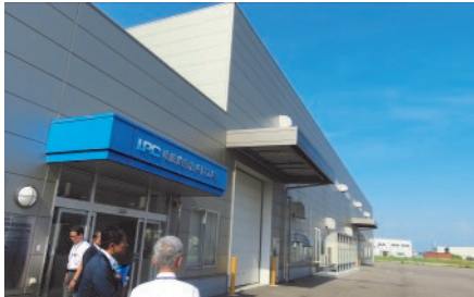
▲貸工場がある事務所棟
